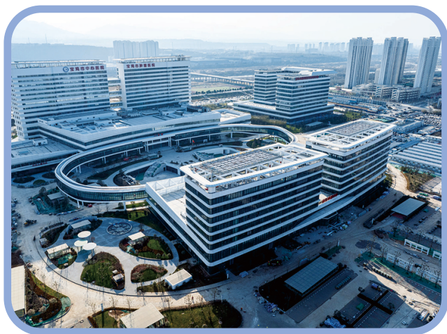
宝鸡市中心医院港务区院区
