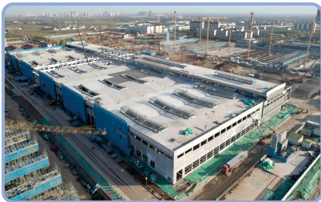
西凤酒4万吨制酒项目2号车间主体封顶
