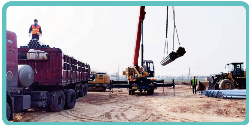
宝鸡机场项目民航站区施工现场
